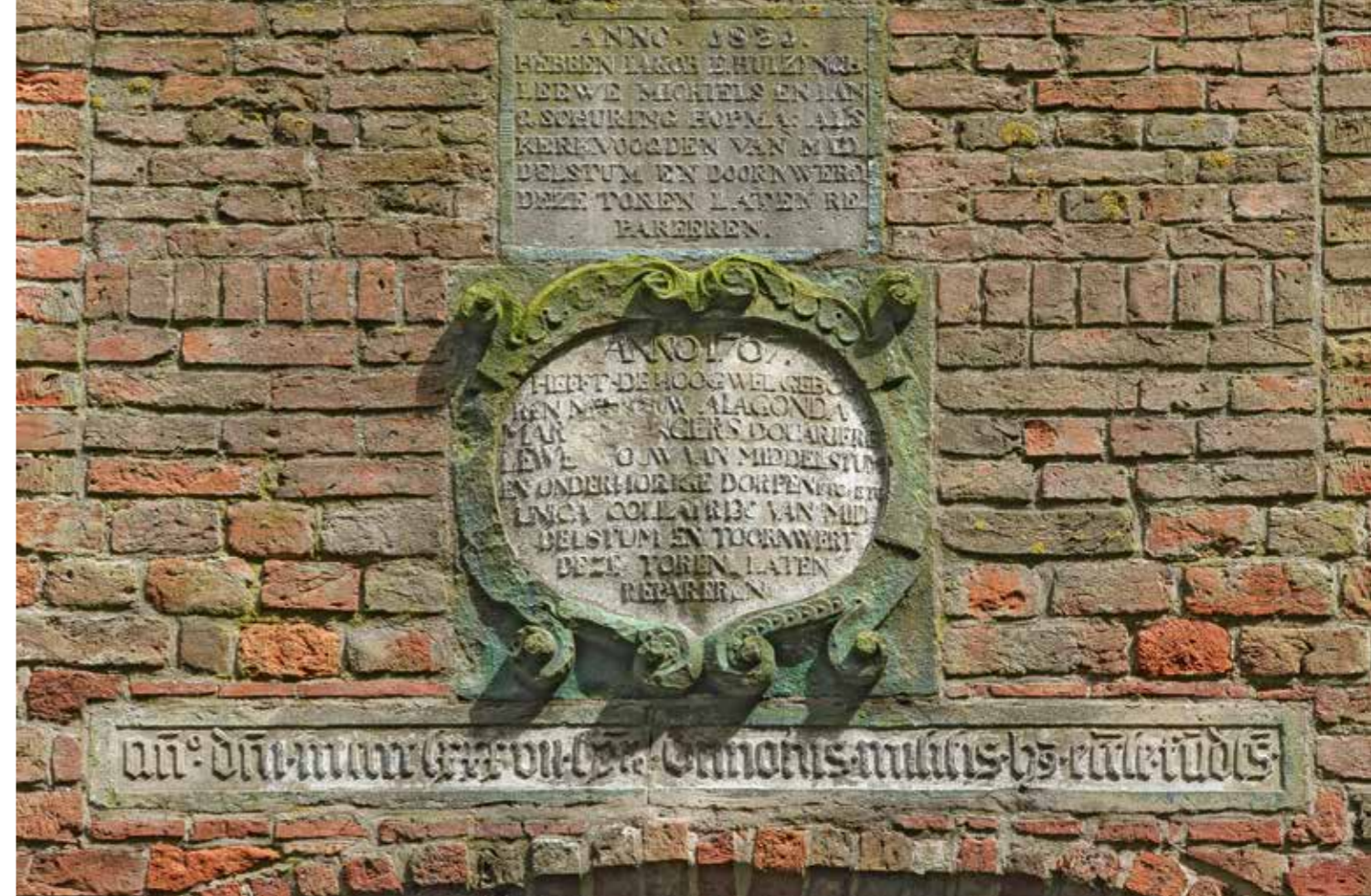
De gevelstenen uit (van beneden naar boven) 1487, 1767 en 1831 boven de toreningang aan de westzijde van de kerk. De oudste steen van 1487 is bij de restauratie naar hier verplaatst, wellicht uitgaande van de gedachte dat de toren in dat jaar gebouwd zou zijn. Foto: Omke Oudeman
